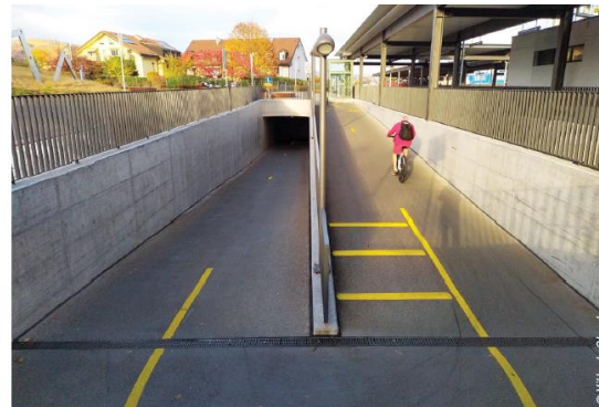
La réalisation d'un passage sous-voies piétons-cycles à la gare de Gland (PA2)
