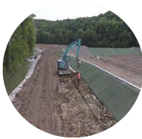
Réalisation de bassins de protection des crues au bord du Foron
