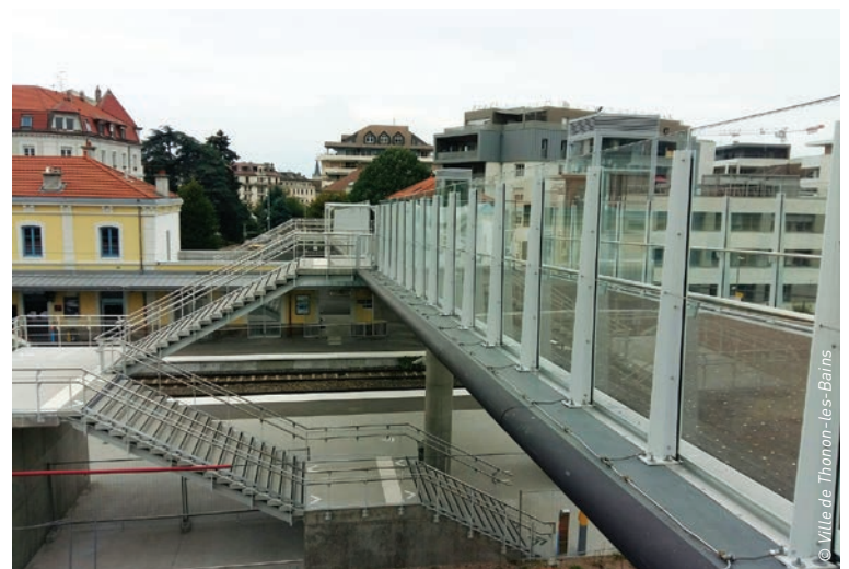
Nouvelle passerelle de l'interface multimodale de Thonon-Les-Bains
