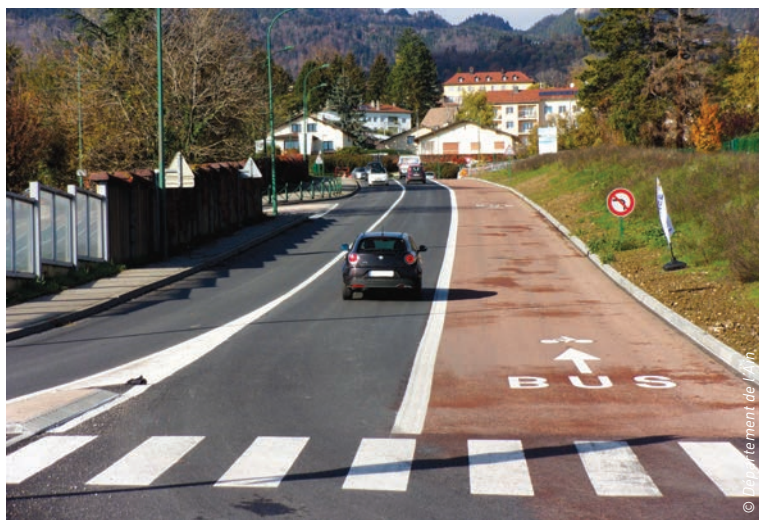
Aménagements BHNS Rue du Lycée à Gex
