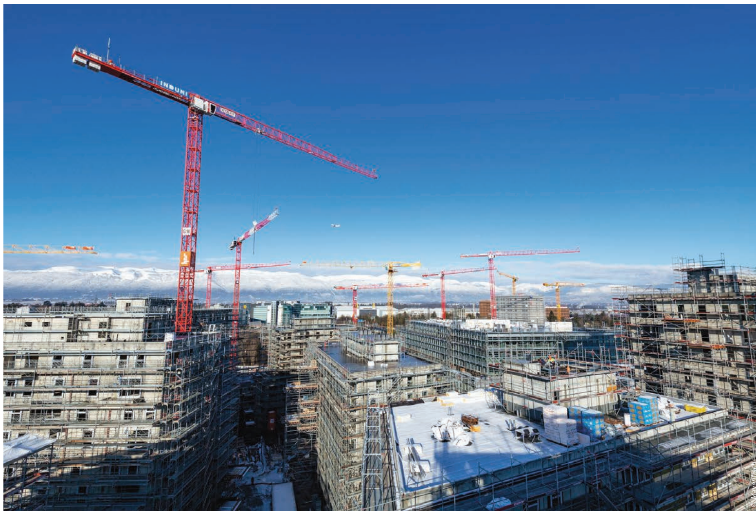
Construction du quartier de l'Étang à Vernier
