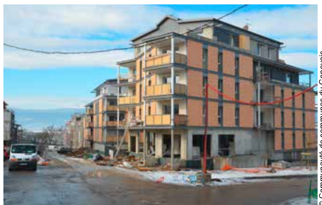
Le quartier de Chabloux en construction
