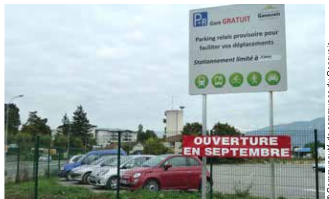
Le P+R provisoire à la gare de St-Julien
